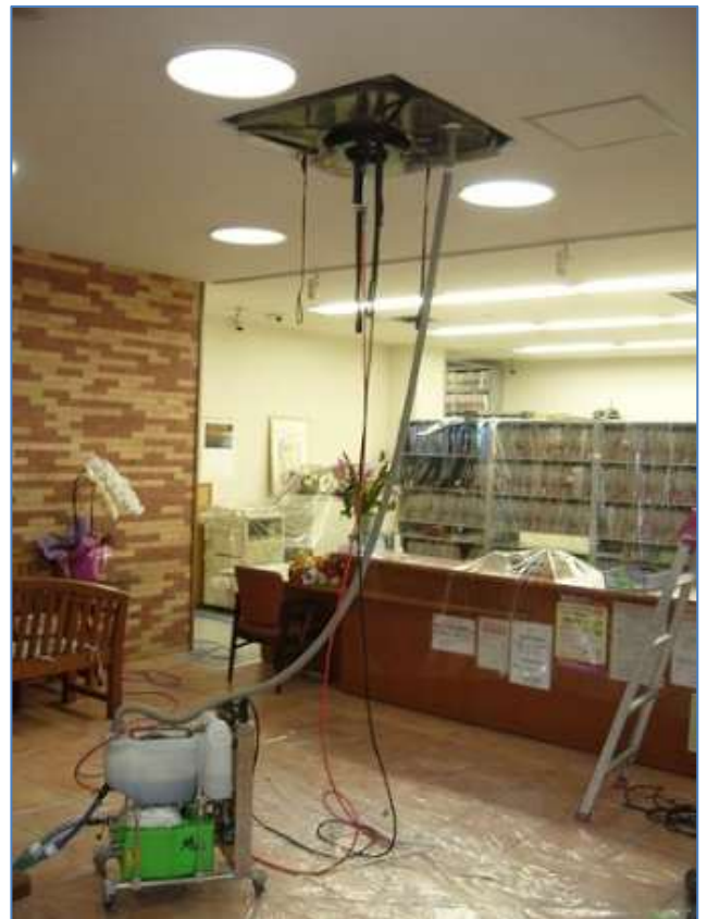
超高压エアコン洗浄ロボットにて洗浄作業中
