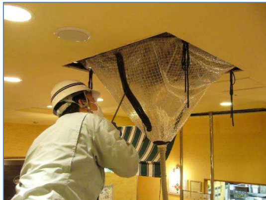
高圧洗浄にて清掃作業中
