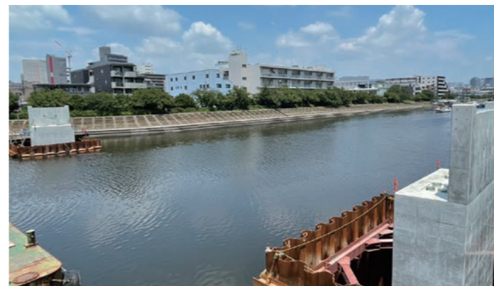
勝島人道橋下部工事(橋脚コンクリート)
