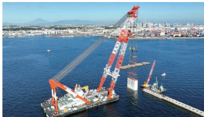
新本牧埠頭護岸築造工事(ケーソン据付)
