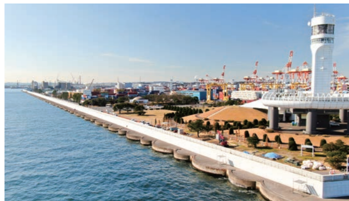
本牧埠頭護岸工事(上部コンクリート)
