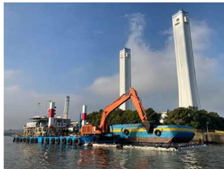
2022 三菱ケミカル浚渫工事
