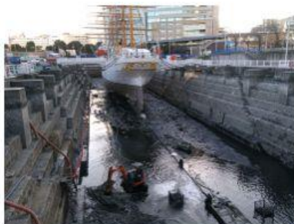
2019 日本丸ドック浚渫及び 排水工事
