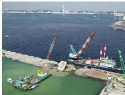
2018 南本牧MC-4岸壁裏込工事
