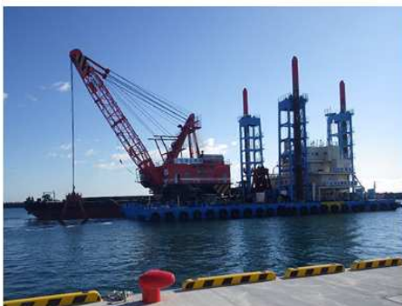
2022 日立港浚渫工事
