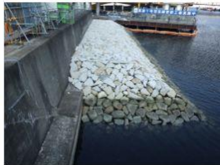
2020 天王洲南運河防潮堤 建設工事
