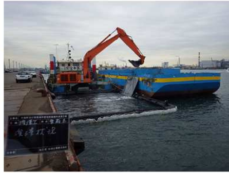
2019 千鳥町及び東扇島岸壁 浚渫工事
