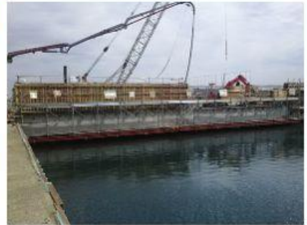
2016 南本牧ふ頭5ブロック 建設工事(その74)
