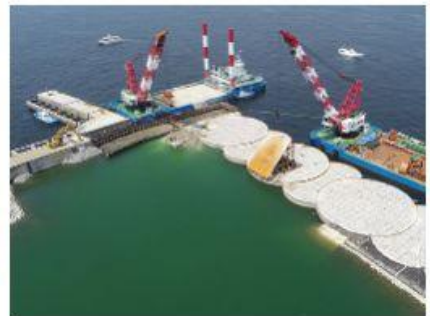
2018 南本牧MC-4岸壁裏込工事
