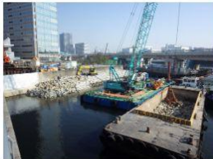
2019 東品川橋架替工事(その3)
