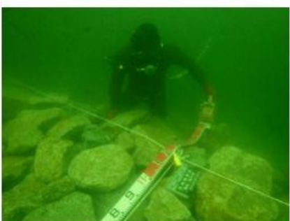
2021 新本牧建設工事(その13)
