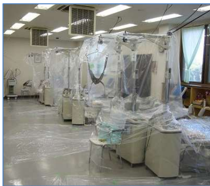
室内養生風景
