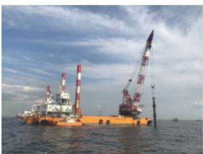
2021 新本牧建設工事(その13)
