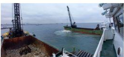
2022 新本牧建設工事 (その22・23)
