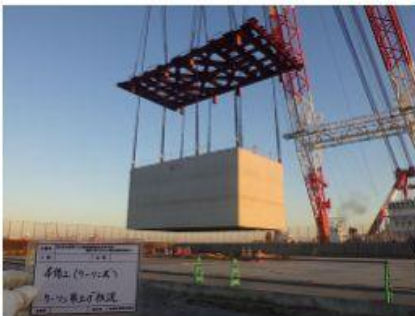
2016 南本牧ふ頭5ブロック 建設工事(その74)
