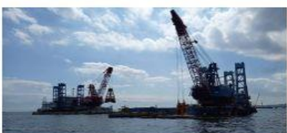
2022 新本牧建設工事 (その22・23)
