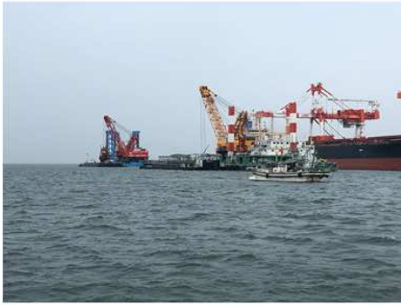
2019 宇部港本港地区(-14m) 浚渫工事
