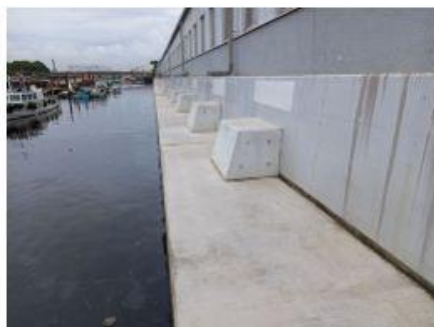
2021 日産自動車横浜工場 陥没補修工事
