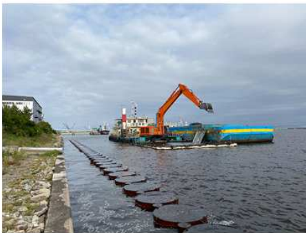
2021 東雲防潮堤建設工事 (その3)
