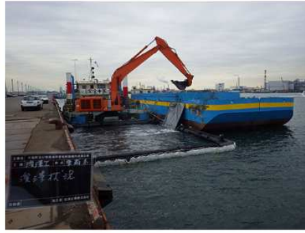
2019 千鳥町及び東扇島岸壁 浚渫工事
