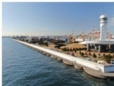
2020 本牧D突堤災害復旧工事・パラペ ット高上げ工
