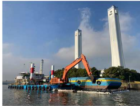
2022 三菱ケミカル浚渫工事
