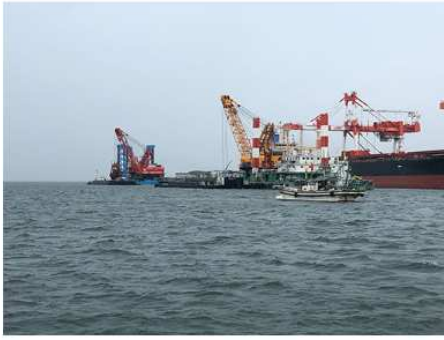
2019 宇部港本港地区(-14m) 浚渫工事
