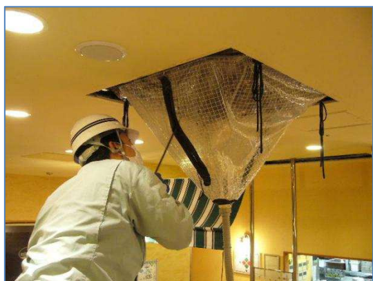
高圧洗浄にて清掃作業中
