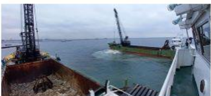
2022 新本牧建設工事 (その22・23)
