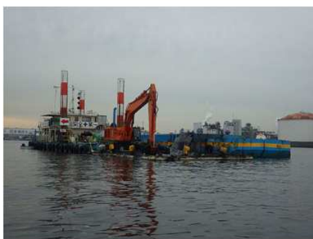
2017 殿町羽田空港線内航路 浚渫工事
