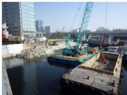
2019 東品川橋架替工事(その3)
