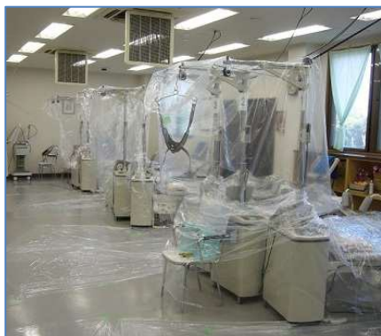
室内養生風景
