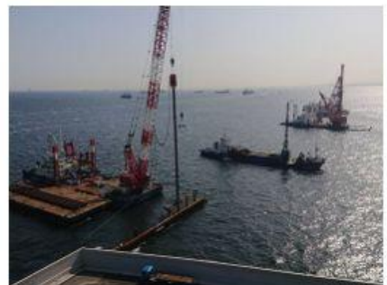
2021 新本牧建設工事 (その10・12・13)
