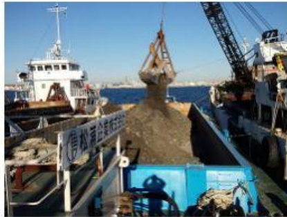
2015 南本牧地区岸壁(-18m) 築造工事(その2)
