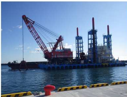
2022 日立港浚渫工事
