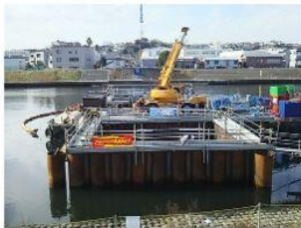
2015 鶴見川水管橋撤去工事
