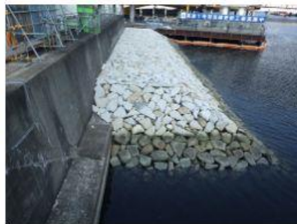
2020 天王洲南運河防潮堤 建設工事
