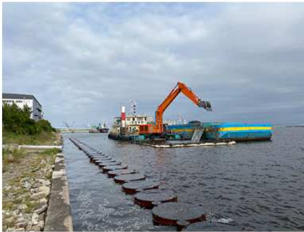
2021 東雲防潮堤建設工事 (その3)
