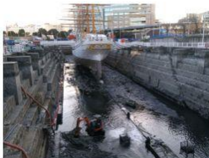
2019 日本丸ドック浚渫及び 排水工事
