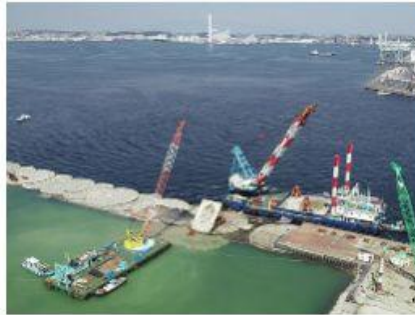
2018 南本牧MC-4岸壁裏込工事
