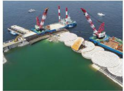
2018 南本牧MC-4岸壁裏込工事
