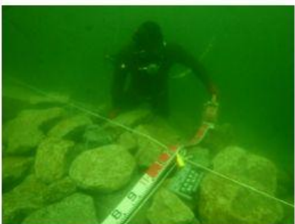
2021 新本牧建設工事(その13)
