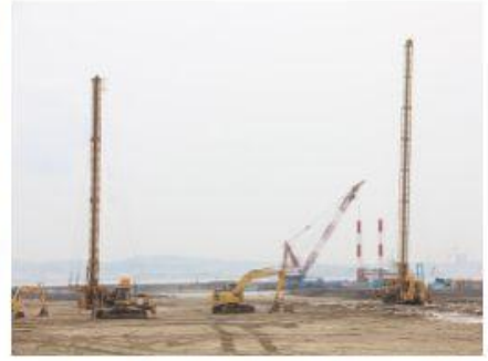
2018 南本牧埋立工事(第4ブロック地 盤改良工その14)
