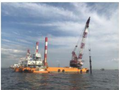
2021 新本牧建設工事(その13)
