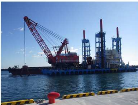
2022 日立港浚渫工事
