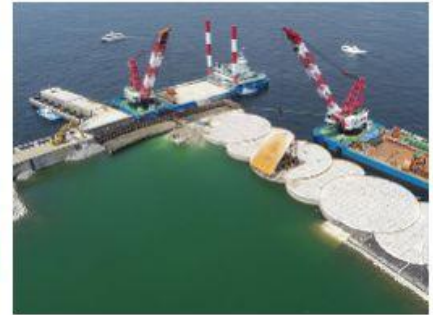
2018 南本牧MC-4岸壁裏込工事
