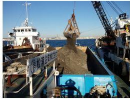
2015 南本牧地区岸壁(-18m) 築造工事(その2)
