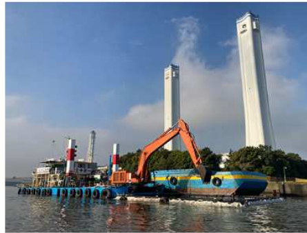
2022 三菱ケミカル浚渫工事
