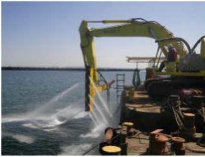
2015 南本牧ふ頭第5ブロック 建設工事(その54)
