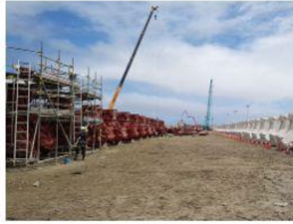
2016 鹿島港外港地区中央防波堤付属 施設消波工事（その3）
