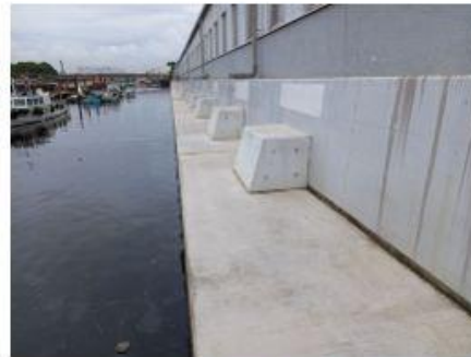
2021 日産自動車横浜工場 陥没補修工事
