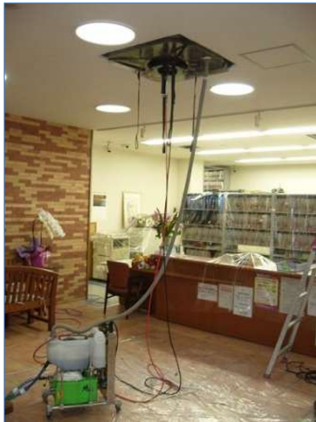
超高圧エアコン洗浄ロボットにて洗浄作業中
