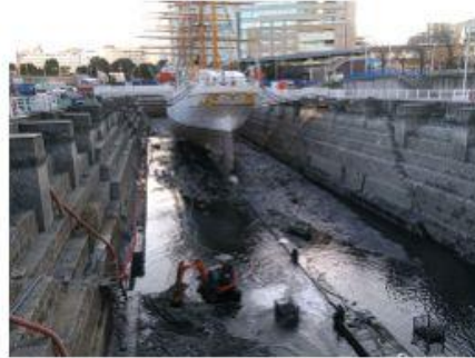
2019 日本丸ドック浚渫及び 排水工事
