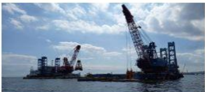
2022 新本牧建設工事 (その22・23)
