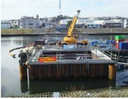
2015 鶴見川水管橋撤去工事
