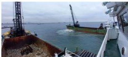
2022 新本牧建設工事 (その22・23)
