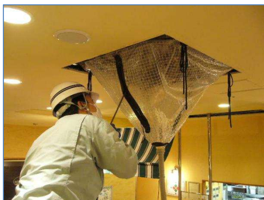
高圧洗浄にて清掃作業中
