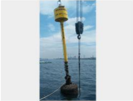
2019 大黒B灯標整備工事
