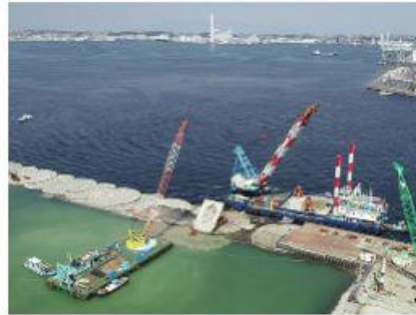
2018 南本牧MC-4岸壁裏込工事
