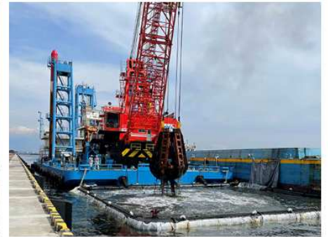
2022 大黒ふ頭岸壁改良工事 (その7)
