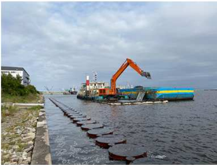
2021 東雲防潮堤建設工事 (その3)
