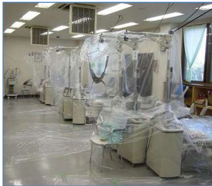
室内養生風景
