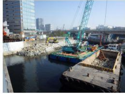
2019 東品川橋架替工事(その3)
