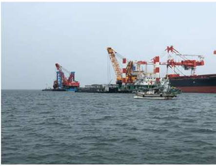
2019 宇部港本港地区(-14m) 浚渫工事
