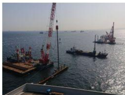
2021 新本牧建設工事 (その10・12・13)
