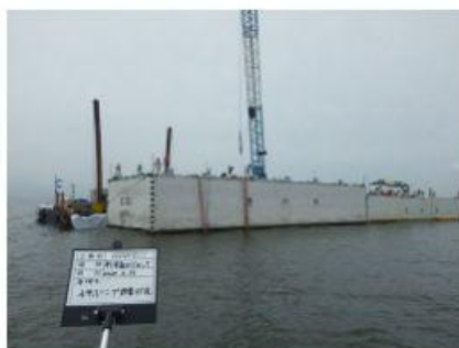
2020 新海面Dブロック 南側護岸建設工事
