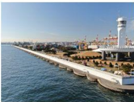
2020 本牧D突堤災害復旧工事・パラペ ット嵩上げ工
