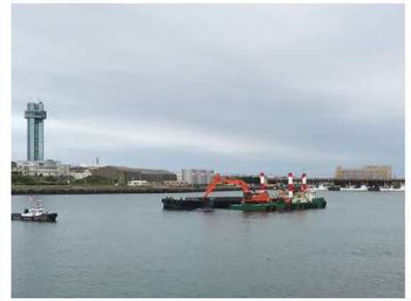
2021 銚子漁港流通基盤整備工事
