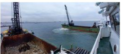
2022 新本牧建設工事 (その22・23)
