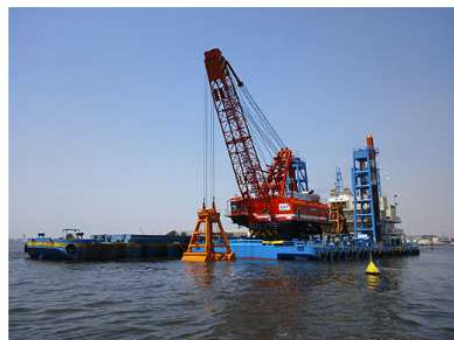
2013 平成25年度市川泊地 浚渫工事
