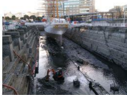
2019 日本丸ドック浚渫及び 排水工事
