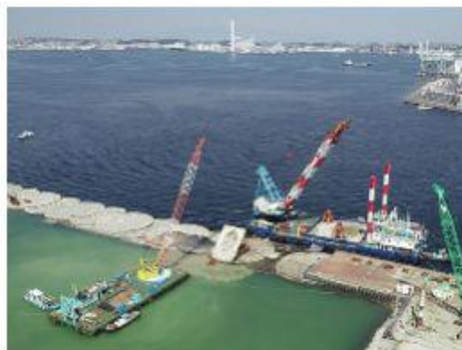
2018 南本牧MC-4岸壁裏込工事
