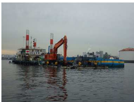
2017 殿町羽田空港線内航路 浚渫工事
