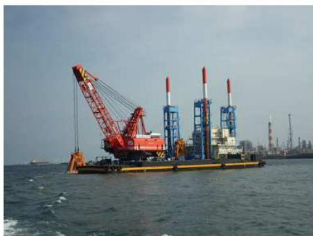
2017 鹿島港外港地区浚渫工事
