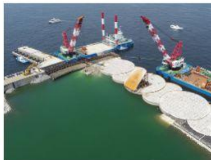
2018 南本牧MC-4岸壁裏込工事
