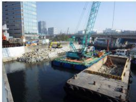
2019 東品川橋架替工事(その3)
