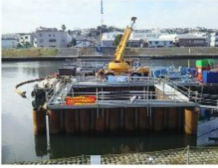
2015 鶴見川水管橋撤去工事
