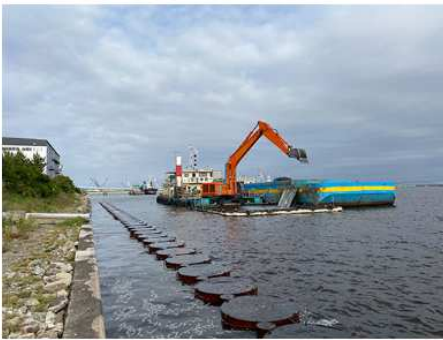
2021 東雲防潮堤建設工事 (その3)
