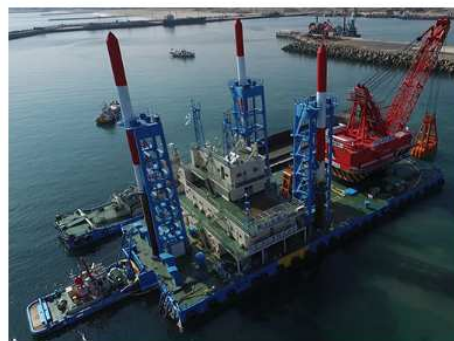
2017 常陸那珂港打継場浚渫工事
