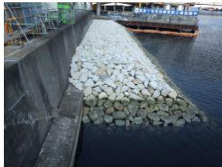
2020 天王洲南運河防潮堤 建設工事
