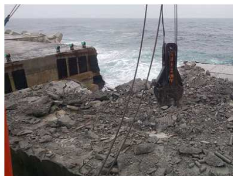
2018 むつ小川原港防波堤 (災害復旧築造)工事
