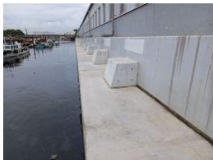
2021 日産自動車横浜工場 陥没補修工事
