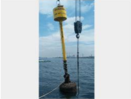
2019 大黒B灯標整備工事
