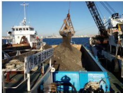
2015 南本牧地区岸壁(-18m) 築造工事(その2)
