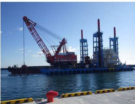
2022 日立港浚渫工事
