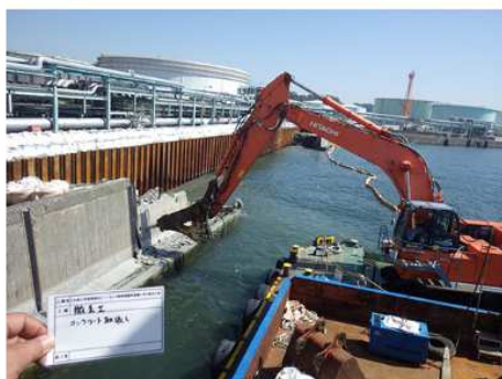
2018 JXTG根岸護岸復旧工事
