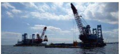
2022 新本牧建設工事 (その22・23)
