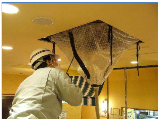
高圧洗浄にて清掃作業中
