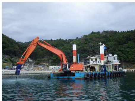
2015 佐藤造船所(宮城県石巻) 工場新築工事
