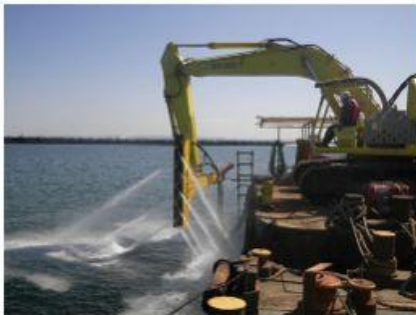
2015 南本牧ふ頭第5ブロック 建設工事(その54)
