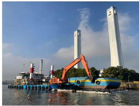
2022 三菱ケミカル浚渫工事
