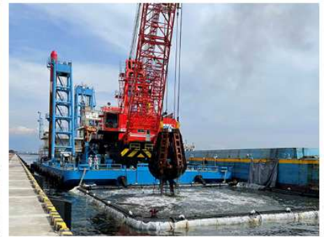
2022 大黒ふ頭岸壁改良工事 (その7)
