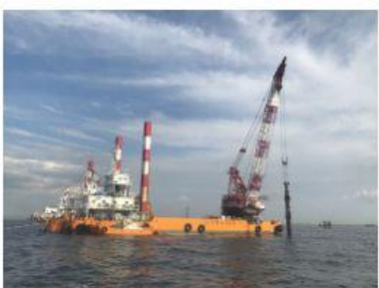
2021 新本牧建設工事(その13)
