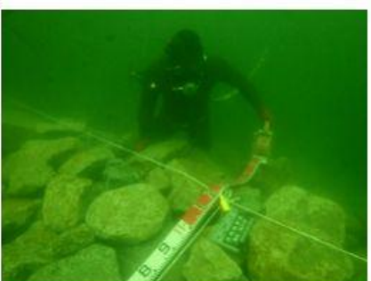
2021 新本牧建設工事(その13)
