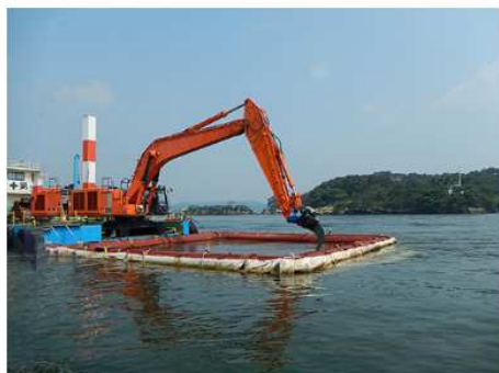
2013 仙台塩釜港塩釜港区 (-7.5m)浚渫工事
