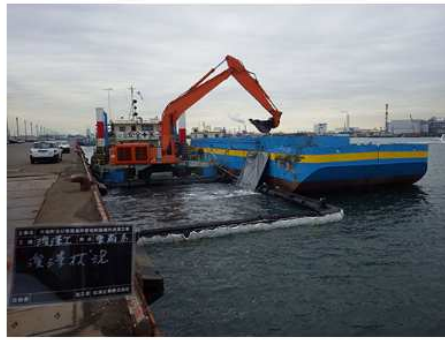
2019 千鳥町及び東扇島岸壁 浚渫工事
