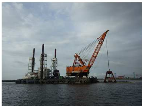
2013 南本牧ふ頭第5ブロック 建設工事(その34)
