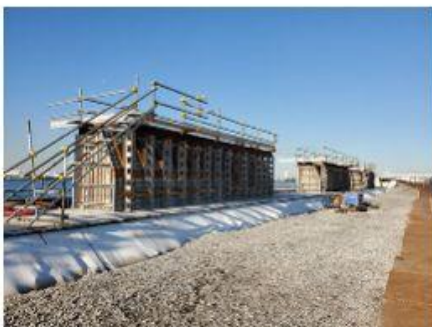
2020 浮島2期廃棄物埋立護岸 災害復旧工事
