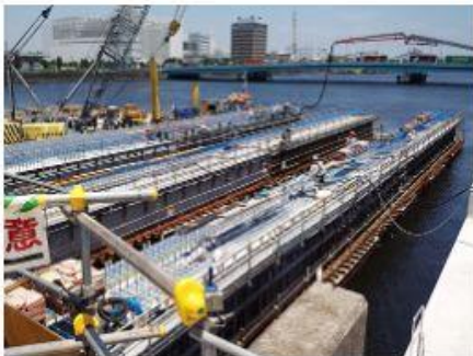
2016 中央防波堤外側埋立地 物揚場建設工事
