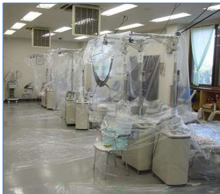
室内養生風景
